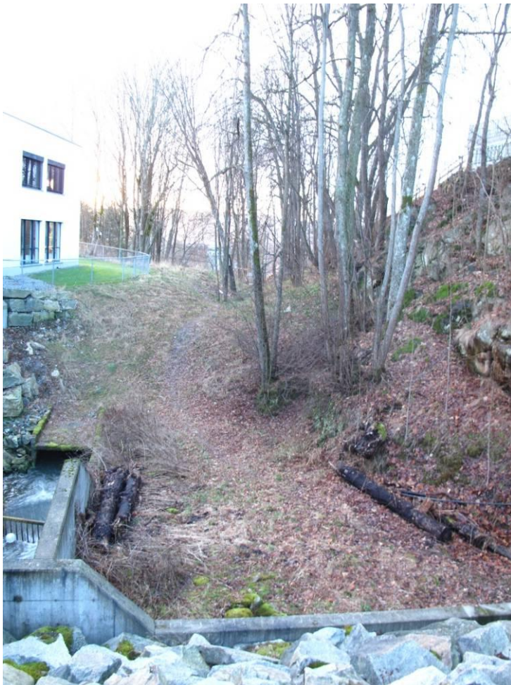
Figur 14. Nedenfor Ulleruddammen, sett mot sør. Dammen er oppdemt med en stor steinrøys og bekken regulert med betongkanter og videre lagt i rør gjennom edelløvslogen. Bekken er av liten verdi, og ikke kartlagt som naturtype. Lokaltiteten "Ullerud skog" er her noe redusert som følge av bygningen til og plen til venstre som allerede er gjennomført. Foto: Steinar Vatne.
